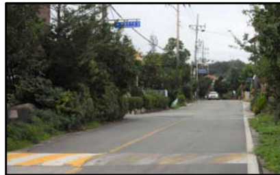
〈사진 145〉 자활촌 마을 도로
