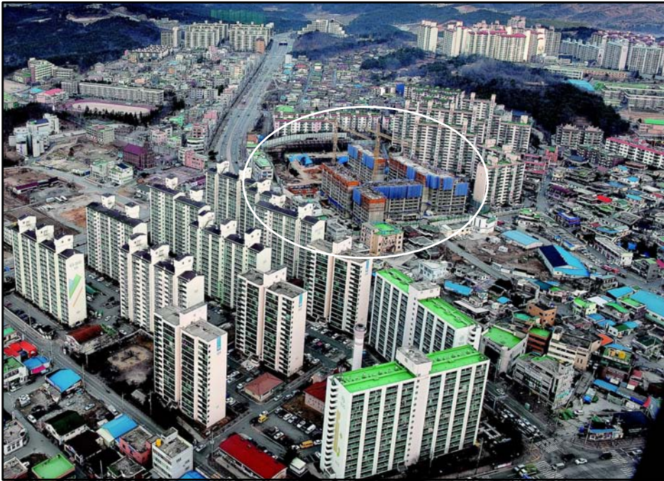
〈사진 12〉 하우스토리 아파트 공사 모습
