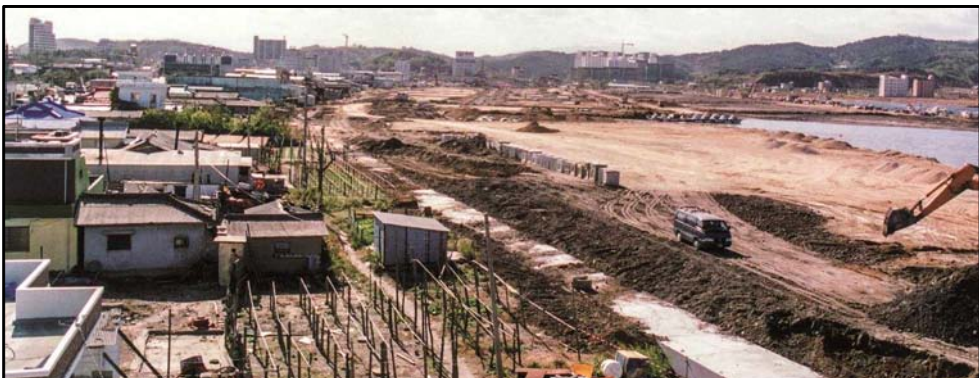
〈사진 7〉 청초호 청호동 쪽 매립공사 현장
