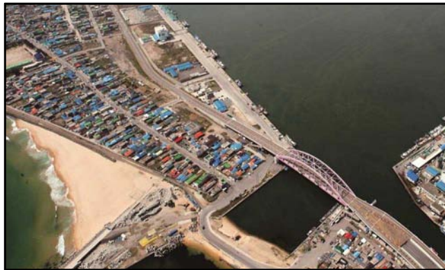
〈사진 10〉 신수로 개설 공사 14)
