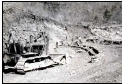
<사진 60> 미시령 도로 개설 공사중(1959) 65)
